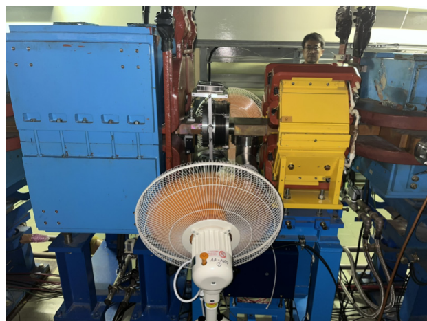
図6 NW9 ダクトの強制空冷
