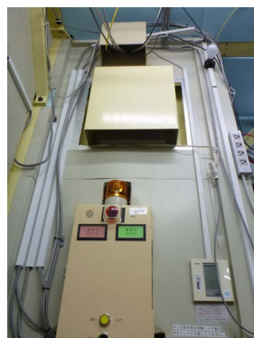
図2 BL-6Cハッチ内に取り付けた換気扇
