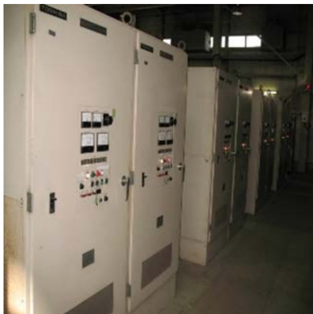
図 2 製作後 32 年が経過して老朽化が著しい 8 台の未更新 4 極電磁石電源 (QCN)。
