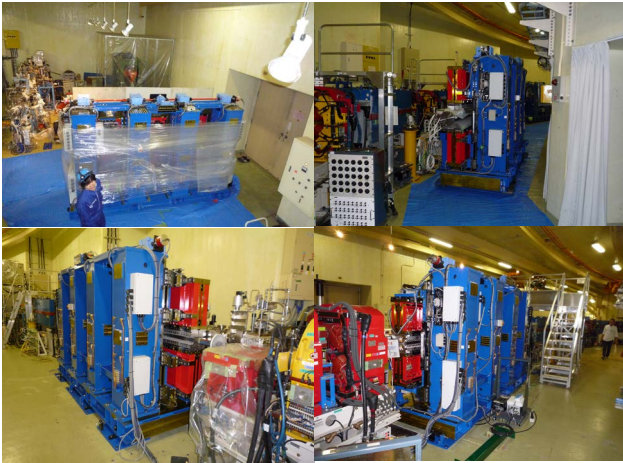
図1 上図は U#13 (APPLE-II 型可変偏光アンジュレータ) を PF 光源棟内に搬入・移動している様子。下図は、U#13 を B12-B13 間の直線部に、U#28 を B27-B28 間の直線部に設置した様子を示す。
