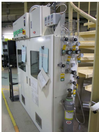
図 1 シリンダーキャビネット。バランスガス (窒素またはヘリウム) との混合が可能。
