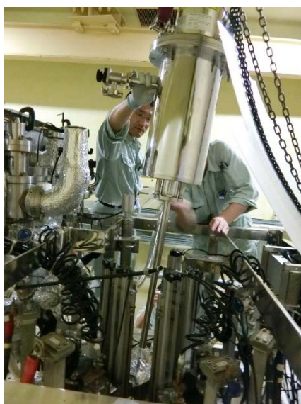
図 1 再液化機を超伝導ウィグラー本体に取り付けるリングトンネル内の作業の様子
