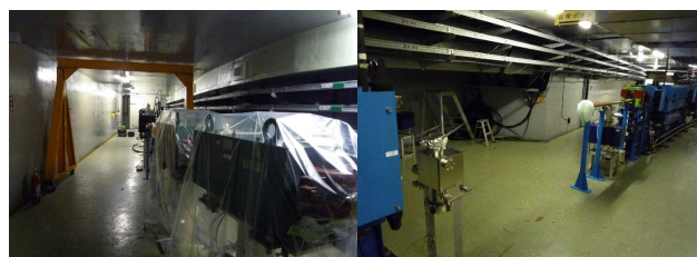
図4 写真はPF-AR 現ビーム入射路に設置してある偏向電磁石の一部(左)、南東直線部(SE12-13間)の真空ダクトをはずし、運搬路を確保した様子(右)。
