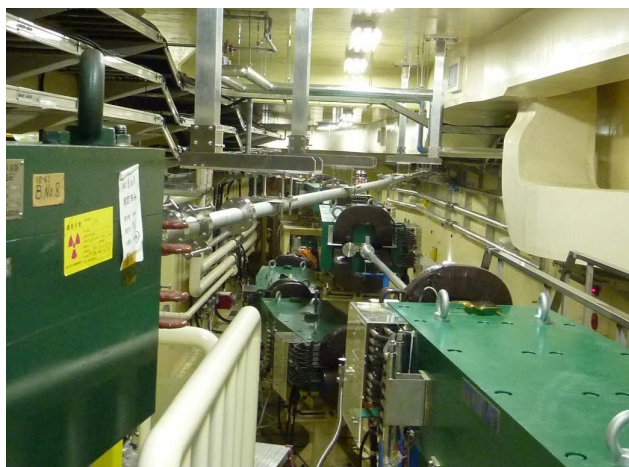
図3 PF-AR 直接入射路のKEKB 入射路との交差部：PF-AR 用6.5 GeV 電子が、KEKB 入射路(HER, LER)の上空を通過する。
