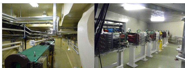
図5 PFAR-BT の KEKB-BT との公差部。KEKB-HER-BT の偏向電磁石の上を PFAR-BT の真空ダクトが通過する(左図)：PF-AR リング入射点手前の三角部屋に設置された電磁石(右図)。
