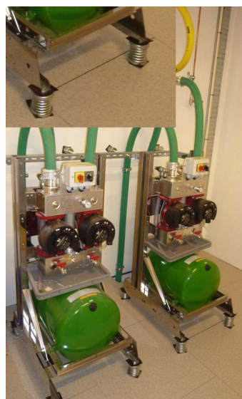
図 4 スプリングを挟んだ冷却水ポンプの設置。台車に乗ったスクロールポンプなども含め、機械振動を引き起こすもの全てにスプリングが挟んであった。
