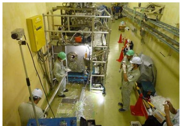
図1-1 ビームダクト交換作業中の超伝導ウィグラー全景
