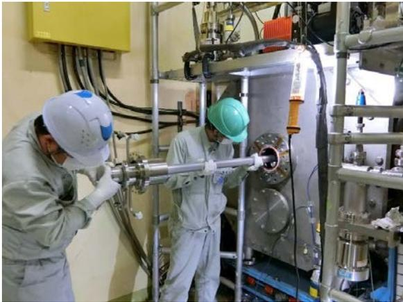
図 1-2 交換用ビームダクトの挿入
