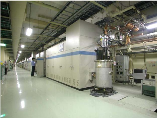
図2 入射器クライストロン・ギャラリに設置されている大電力パルスモジュレータ電源とクライストロン。
