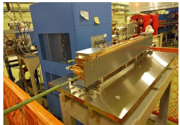
図 1-1 新規に製作されたセプタム電磁石（S2）の磁場測定の様子。手前から延びるサーチコイルによりパルス磁場を測定している。
