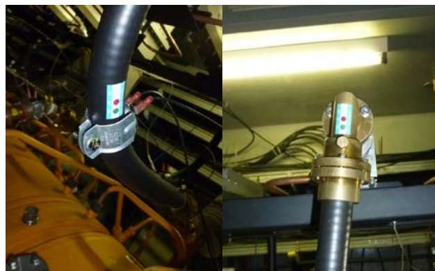
図9 故障した HOM ケーブルのサーモラベル表示。(左) 中央部、(右) ダミーロード側。いずれも50℃以上を示す赤色と60℃以上を示す緑色のサインが表示されていた。
