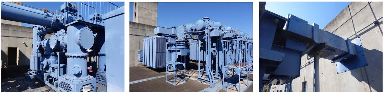
図1 PFエネルギー・センター内の設備、左から、共同溝からの66 kV受電部、6.6 kVへの変圧器、6.6 kVのブスバーを覆うダクト。ダクトの下にあるメッシュから多湿の温風が侵入したと考えられる。
