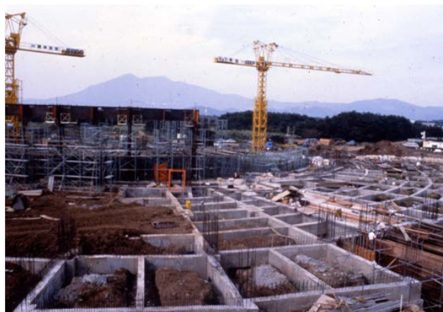
PF 光源棟建設の様子（1980年）
