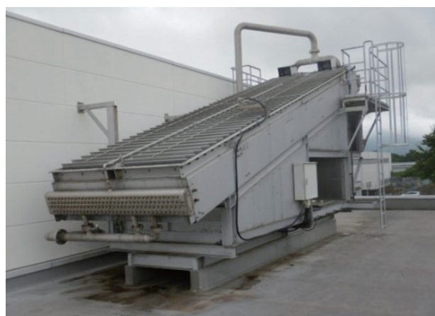
図 2-17 クライストロンで発生した水蒸気を冷却するためのエアフィン・クーラー。
