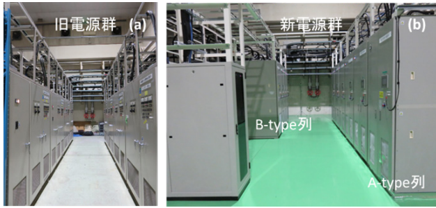
図2 四極および六極電磁石に使われる中型電源。更新前の旧電源 (a) ならびに更新後の新電源 (b) の写真。
