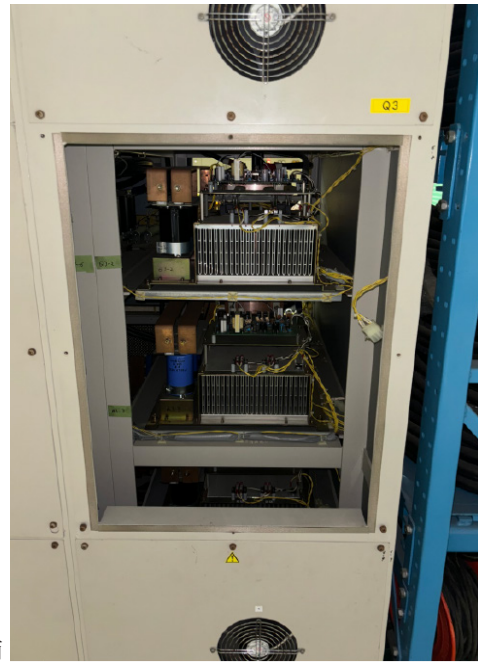
図2 IGBTのファン故障のため、加熱インターロックで停止した四極電磁石電源。一時対処として、外部より強制空冷することで運転を継続した。その後、粉塵の侵入対策としてフィルターを設置するなどの対処を実施した。
