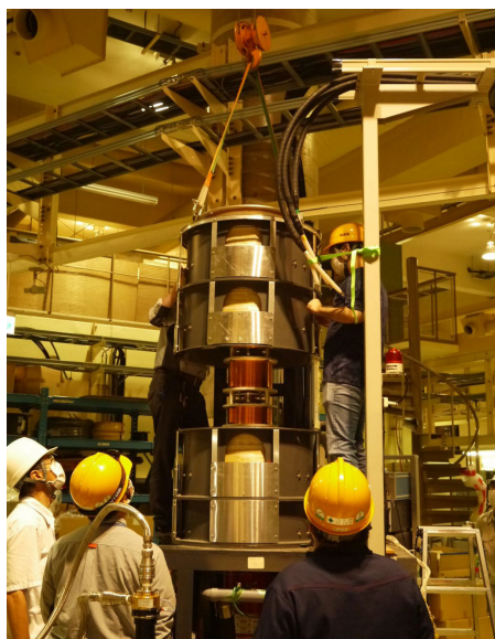
図4 クライストロン交換作業
