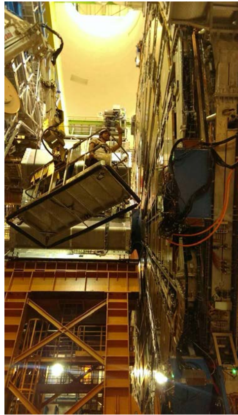
図 2 Endcap ミューオン測定器 (TGC) の整備作業
