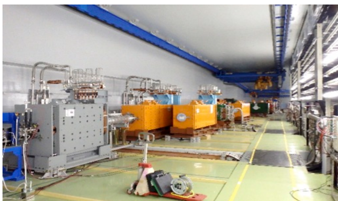
図 2 スイッチャード内の機器配置の様子。奥側が既存のビームライン。手前に配置されている磁石群が新一次ビームライン用の機器である。
