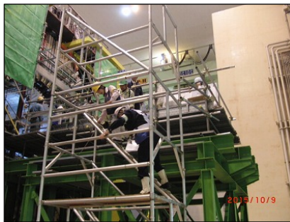
昇降設備の点検
