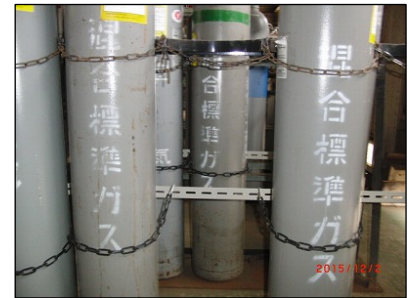
既存ポンベスタンドの改良例 (ポンベ一本毎の固定)
