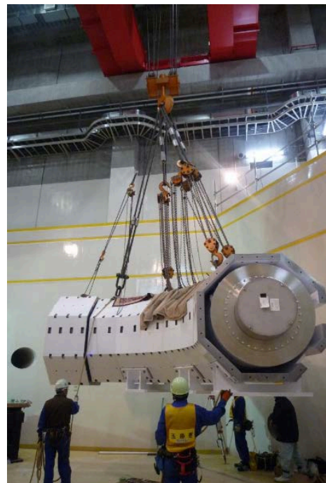
図 1 COMET 実験ホールに設置される湾曲ソレノイド超伝導電磁石。
