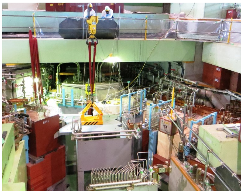
Figure 2 ビームライン遮蔽体の取り出し作業。
