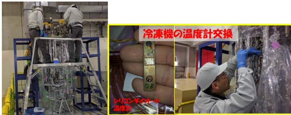
図7 COMET用冷凍機の温度センサー交換作業
