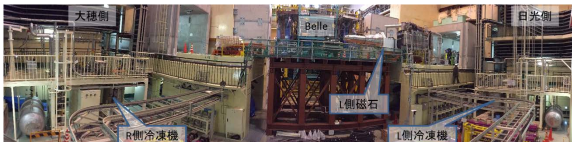
図8 筑波実験ホール内の冷凍機の整備
