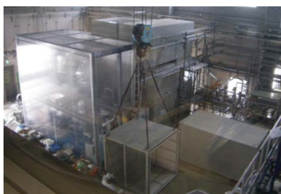
図 1 圧縮機防音室の解体
