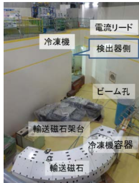
図 5 工事中のハドロン南実験棟 COMET ターゲットエリア
