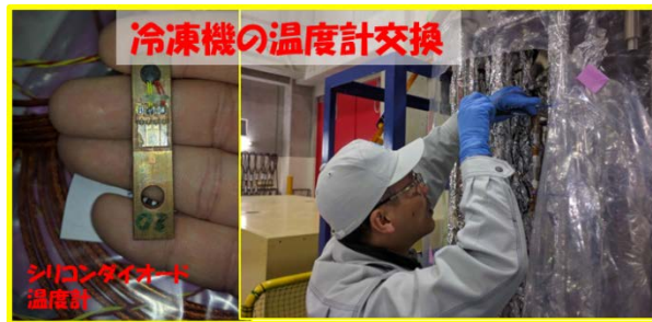
図 6 COMET 用冷凍機の温度センサー交換作業
