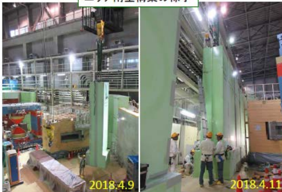
エリア南壁構築の様子
