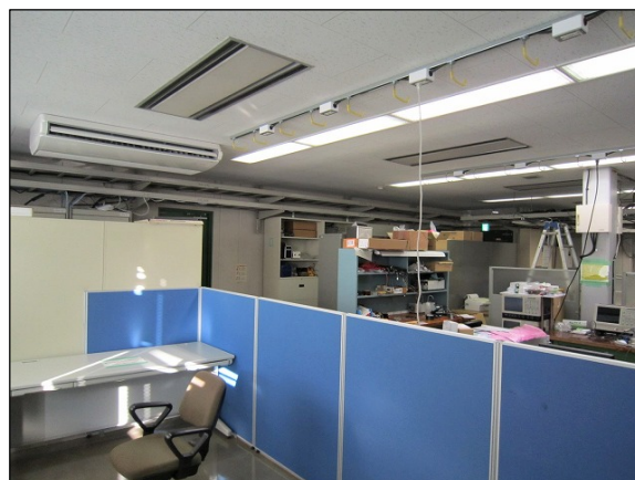
新たに設置した空調機と天井配線(2F 側室)
