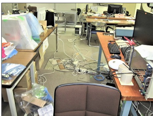
天井配線施工前の乱雑な床上配線の状況
