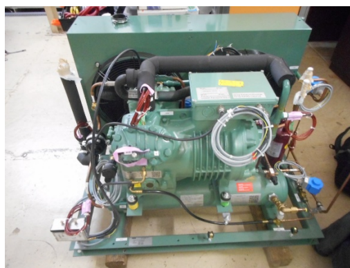
(d) 圧縮機の交換
