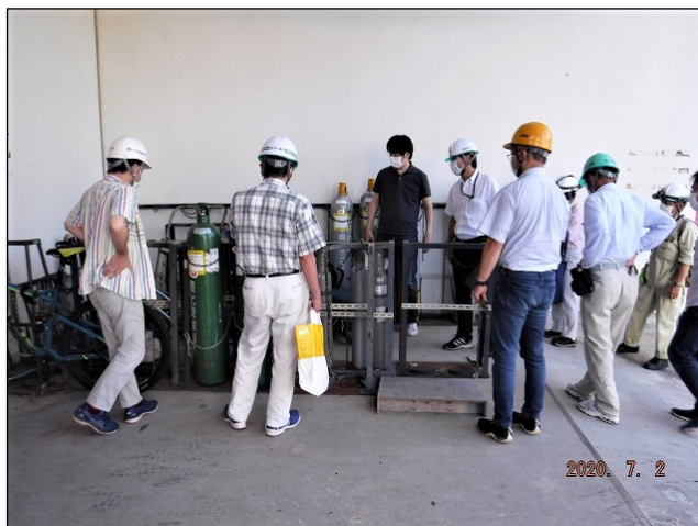
安全巡視の様子(ボンベの保管状況の確認)
