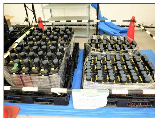
大型UPSから取り出した鉛蓄電池
