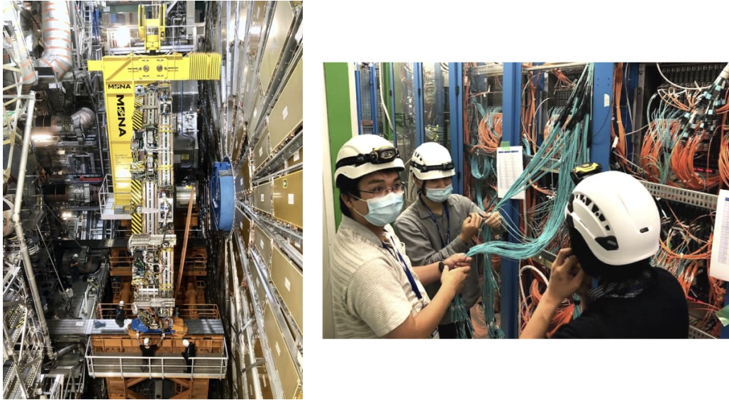
Figure 2: NSW のインストール時の状況（左）とインストールに伴うミュオントリガーエレクトロニクス周りの接続・同期試験の様子（右）。
