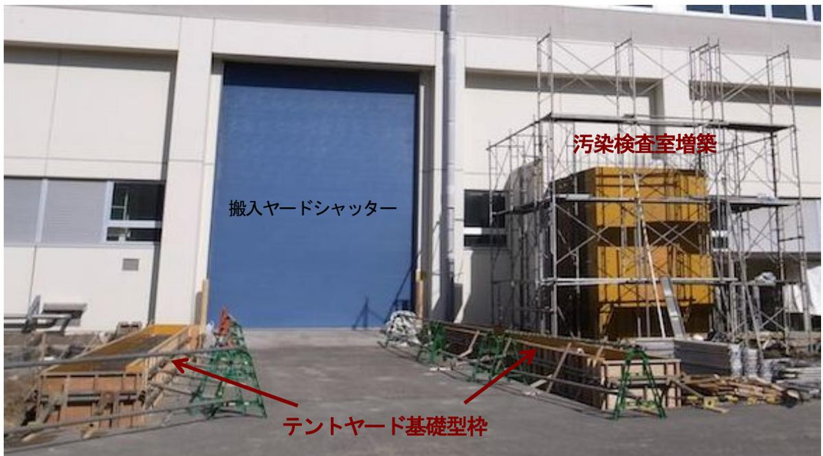
図3 ハドロン実験ホール南側の工事。搬入ヤードの外側にテントヤードを増築し、トラック等による搬入と搬出の際に、ホール内の空気が直接外部に漏れないようにする。汚染検査室を設置して、ホールの入退域の放射線管理を行う事ができるようにする。
