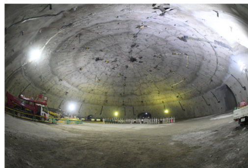
完成した本体空洞ドーム部(直径69m, 高さ21m)
