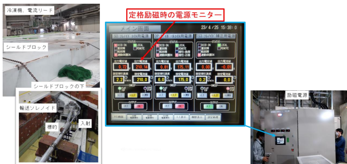
図 2 輸送ソレノイド ビーム運転(Phase \alpha )の実施(左)と定格励磁(3 テスラ)成功時の 210 A 電源表示(中央、右)
