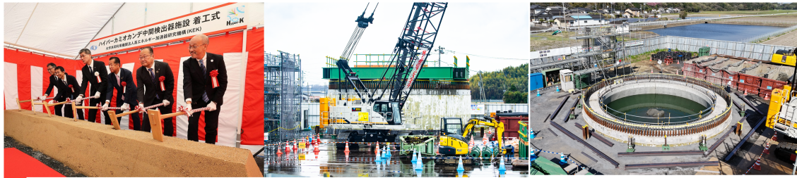
IWCD 着工式(左), 圧入前の第 1 ロッドの状況(中), 圧入後の第 1 ロッドの状況(右)
