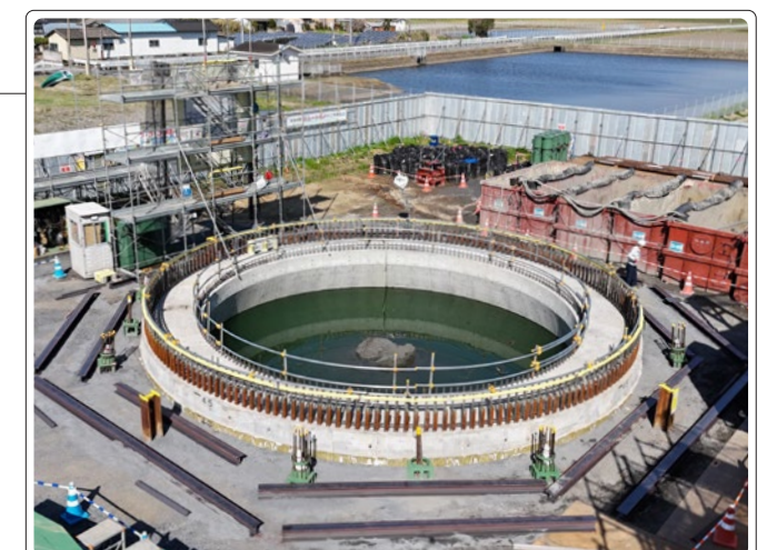
東海キャンパスに建設中の中間検出器IWCD。ニュートリノ発生地点から約1km下流に設置します。
