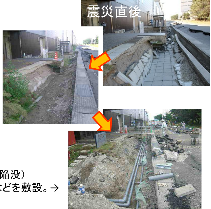
↑リニアック棟前の大きく陥没した道路
