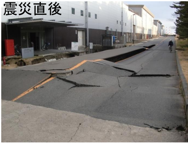
↑リニアック棟前の大きく陥没した道路
