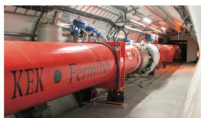
トンネル内に設置されたビーム衝突点磁石群
