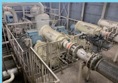
ヘリウムガスを液化して超伝導加速空洞を4Kに冷却。希少資源であるヘリウムガスの消費が少ないヘリウム液化冷凍システム!
