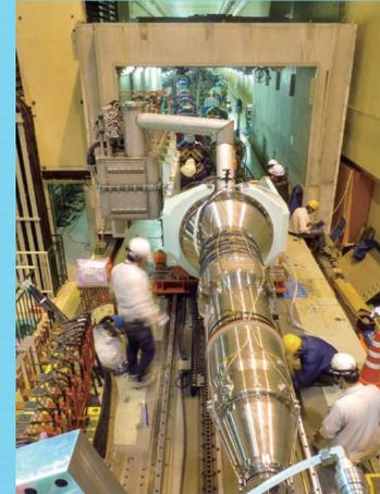
複数の超伝導電磁石群で構成され、衝突点で最終形状にビームを絞り込む
