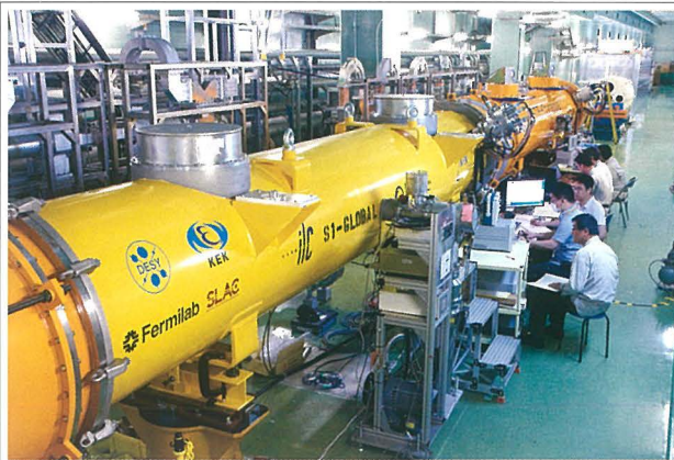
STF棟トンネル内に設置された実機
